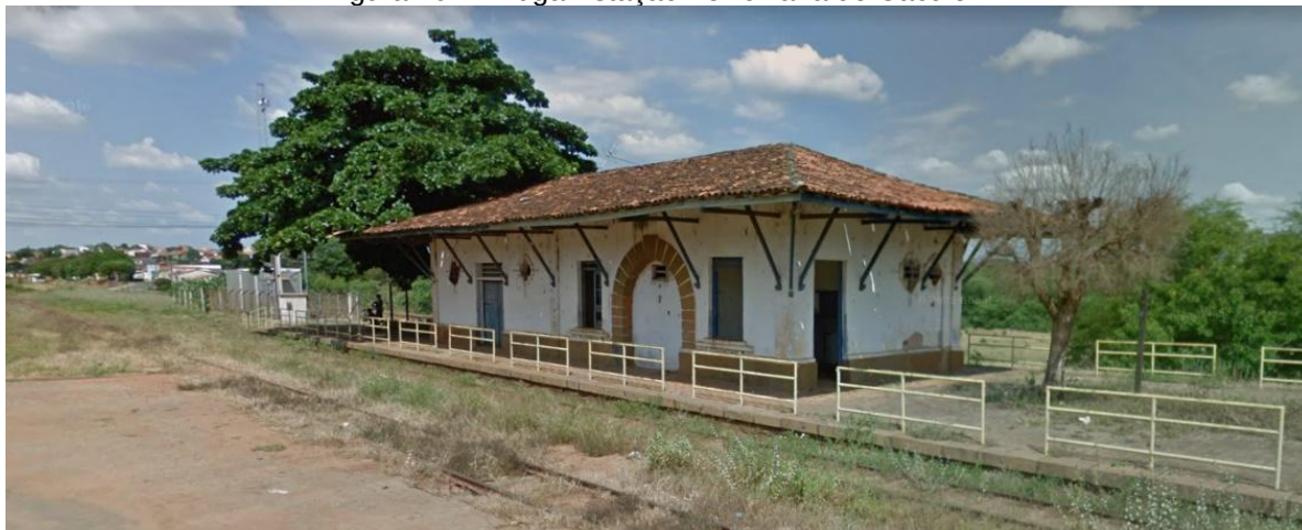
Figura 20 – Antiga Estação Ferroviária de Caculé
